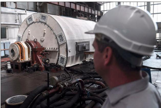
В процессе работ была проведена модернизация системы охлаждения обмотки и железа статора. По итогам испытаний турбогенератор подтвердил все технические параметры.
