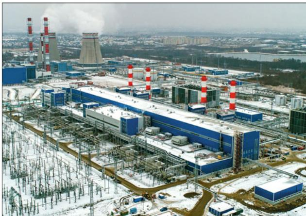
Топливом для турбин ТЭС является природный газ. Его проектные параметры по чистоте, температуре, давлению и расходу обеспечивает система комплексной подготовки газа «ЭНЕРГАЗ», которая включает многоблочный пункт подготовки газа, дожимную компрессорную станцию из четырёх агрегатов, модуль управления.
