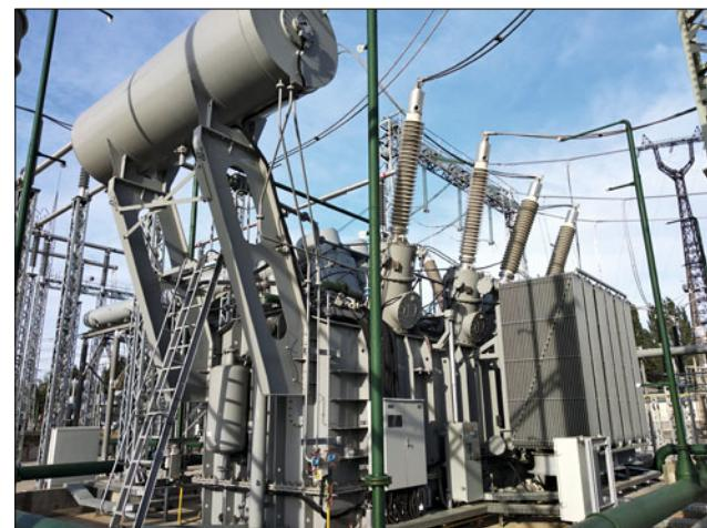
Введение фазоповоротного трансформатора в опытную эксплуатацию позволяет снизить затраты на присоединение увеличенной мощности Волжской ГЭС к энергосистеме в 6 раз и более. Экономический эффект от этого технического решения превышает 3 млрд руб.
