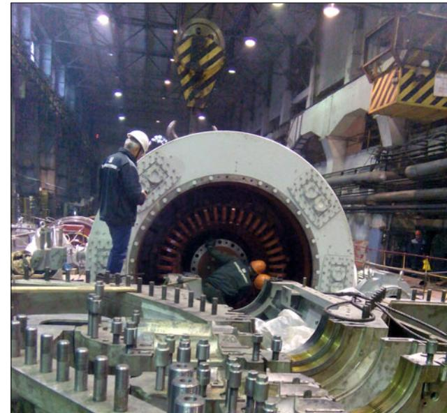
**В конце апреля произведен пробный пуск турбогенератора типа ТГП-6,3-6000-2УЗ мощностью 6 МВт на Южной тепловой электростанции в Рубцовске.** После окончания монтажных и пусконаладочных работ генератор был включён в сеть. Пуски прошли успешно, замечаний к турбогенератору и системе возбуждения нет.
