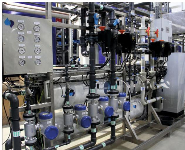
После запуска установки ЭДИ качество воды улучшилось и теперь соответствует самым жёстким требованиям. К примеру, содержание соединений натрия в воде составляет 4 – 6 мкг/дм<sup>3</sup>, кремниевой кислоты – 5 – 8 мкг/дм<sup>3</sup>.
