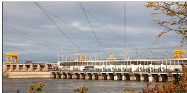
Программа комплексной модернизации Воткинской ГЭС предусматривает замену всех десяти гидроагрегатов гидроэлектростанции, соответствующий договор был подписан с российским энергомашиностроительным концерном “Силовые машины” в 2014 г. Сейчас на станции заменены уже три гидроагрегата, ведётся замена ещё одной машины. Обновление гидроагрегатов позволит повысить мощность Воткинской ГЭС более чем на 10%, до 1150 МВт.
