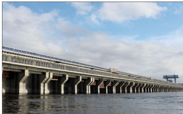
**Мощность Воткинской ГЭС увеличилась на 15 МВт и составляет 1065 МВт. Это стало возможным в результате замены гидроагрегата № 5 в рамках реализации Программы комплексной модернизации РусГидро.** В 2019 г. это уже второе увеличение мощности Воткинской ГЭС. В июле мощность станции была увеличена также на 15 МВт в результате замены гидроагрегата № 7.
