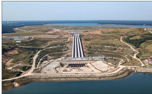
Проект по выравниванию здания строящейся Загорской ГАЭС-2 после непроектной осадки разработан входящим в Группу РусГидро Институтом “Гидропроект”. Он предусматривает использование метода компенсационного нагнетания специальных затвердевающих составов под фундаментную плиту здания. Учитывая сложность и уникальность проекта,
