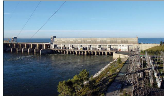
Программа замены гидротурбин Новосибирской ГЭС стартовала в 2012 г. В результате её реализации новые высокоэффективные турбины получили все семь гидроагрегатов станции. Повысилась надёжность работы Новосибирской ГЭС, сократились сроки и стоимость ремонтов. Управление новыми турбинами ведётся с помощью современной микропроцессорной системы, которая обеспечивает контроль работы оборудования с передачей всей информации в автоматизированную систему управления ГЭС.
