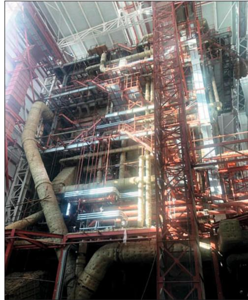
В настоящее время в зданиях и помещениях электростанции выполняется целый комплекс работ: монтаж металлоконструкций котлов, оборудования насосной станции, дробильного устройства, галереи конвейеров. На складе топлива устанавливают противопылевой защитный экран и укладывают бентонитовые маты – современный гидроизоляционный материал. Продолжается строительство железнодорожных путей и внутривиадочных дорог.
