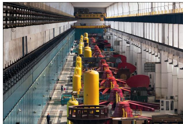
Кроме замены гидроагрегатов на новые, с увеличенной мощностью и более совершенными эксплуатационными характеристиками, в рамках ПКМ будет заменено оборудование открытого распределительного устройства 500 кВ на современное элегазовое оборудование (КРУЭ), обновлены затворы водосливной плотины и другое гидромеханическое оборудование.
