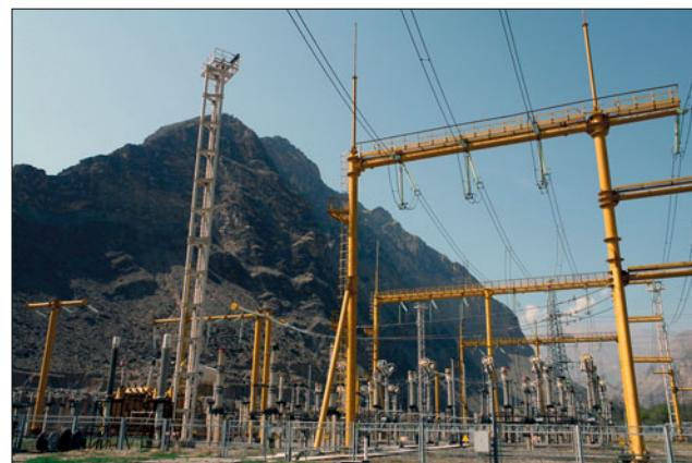
Выключатели и трансформаторы тока, установленные на распределительном устройстве станции, были изготовлены еще в 1991 г. В настоящее время оборудование достигло высокой степени износа, а сами выключатели этой модели не производятся с 2001 г. При модернизации распределительного устройства, которую планируется завершить в 2021 г., предстоит заменить три выключателя напряжением 330 кВ, один выключатель напряжением 110 кВ и девять трансформаторов тока.
