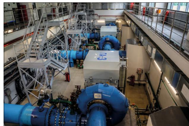
Программа комплексной модернизации Воткинской ГЭС предусматривает замену всех десяти гидроагрегатов станции. Первый гидроагрегат был заменён в 2017 г., в дальнейшем новые машины вводились ежегодно. После завершения работ мощность станции воз-
