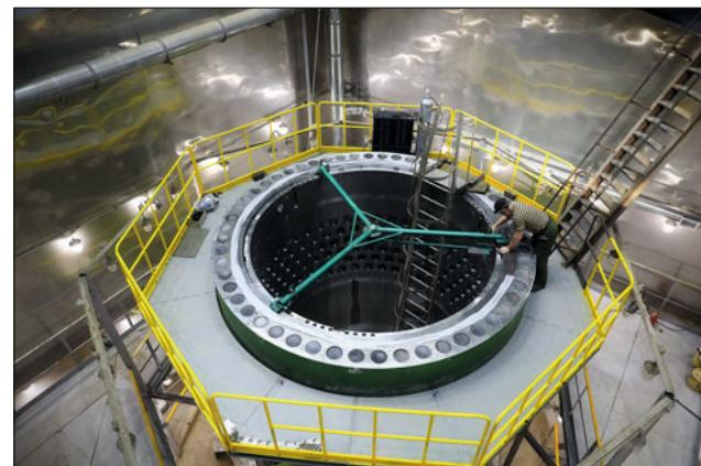
Реактор представляет собой вертикальный цилиндрический корпус с эллиптическим днищем, внутри которого размещается активная зона и внутрикорпусные устройства. Сверху реактор герметично закрыт крышкой с установленными на ней приводами механизмов и органов регулирования и защиты реакторов, а также патрубками для вывода кабелей датчиков внутриреакторного контроля.
