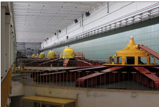
Одновременно с 1 октября 2020 г. мощность Воткинской ГЭС увеличилась на 15 МВт и составляет 1080 МВт. Это стало возможным в результате замены гидроагрегата со ст. № 3,
