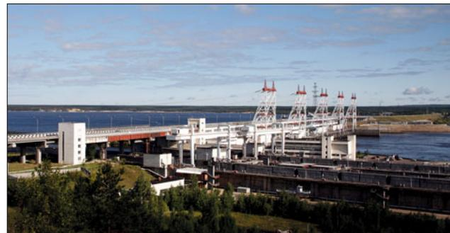
Одновременно на Чебоксарской ГЭС вели в эксплуатацию современную автоматизированную систему диагностического контроля гидротехнических сооружений (АСДК ГТС). Новое оборудование позволяет оценивать безопасность сооружений станции в режиме реального времени, а также оперативно прогнозировать любые изменения их состояния.
