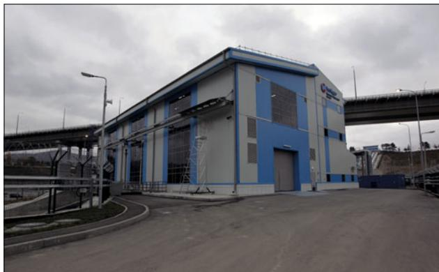
Усть-Джегутинская МГЭС оборудована двумя вертикальными гидроагрегатами мощностью по 2,8 МВт каждый, с поворотно-лопастными турбинами, работающими на расчётном напоре 31 м. Электроэнергия выдается в энергосистему по двум линиям электропередачи напряжением 6 кВ на ПС Головная.
