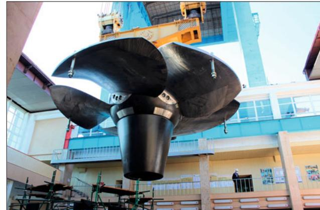
Инвестиционный проект по замене гидротурбин Саратовской ГЭС – один из крупнейших в Программе комплексной модернизации ГЭС РусГидро, он предусматривает замену 22 вертикальных поворотно-лопастных гидротурбин. С 2013 г. в результате модернизации установленная мощность станции уже увеличилась на 67 МВт (с 1360 до 1427 МВт). В перспективе в результате замены всех гидротурбин установленная мощность станции возрастет до 1505 МВт.
