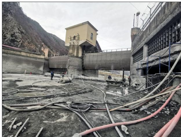
В ходе работ по модернизации головного узла предстоит выполнить значительный объём работ. С помощью закачки специальных затвердевающих составов через пробуренные скважины будет укреплен грунт под сооружениями. Также будут устранены повреждения бетона, а на водосливной грани водосброса и в промыльных галереях водоприёмника смонтируют металлическую облицовку, которая защитит бетон от износа.
