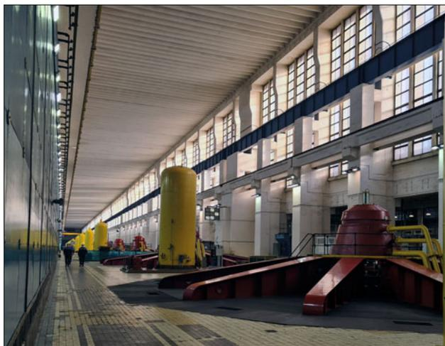
Сегодня на Волжской ГЭС обновили уже 21 гидротурбину и 14 генераторов. Завершить замену всех 22 турбин планируется в 2021 г., генераторов – в 2026 г. Новые гидроагрегаты обладают большей эффективностью, что уже позволило увеличить мощность Волжской ГЭС с 2541 до 2 671 МВт. В перспективе установленная мощность станции возрастет до 2744,5 МВт.
