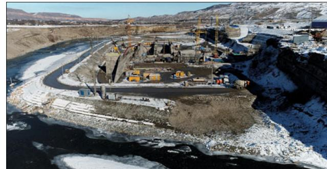
Реализуемый РусГидро гидроэнергетический проект предусматривает строительство на реке Кубань, ниже действующей Зеленчукской ГЭС-ГАЭС двух малых гидроэлектростанций: Красногорских МГЭС-1 и МГЭС-2. Мощность каждой малой ГЭС составит 24,9 МВт, среднегодовая выработка электроэнергии – 83,8 млн кВт·ч.
