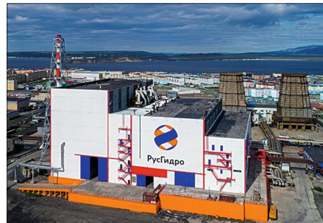
На станции проведена реконструкция котлоагрегатов для использования газа в качестве топлива с внедрением автоматической системы управления, построены внутристанционный газопровод и газораспределительный пункт, смонтированы основные подводящие коммуникации и новая дымовая труба. Все установленное газовое оборудование успешно прошло пусконаладочные испытания.
