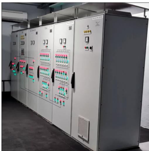
Устанавливаемые сейчас в Мосэнерго системы локализации замыканий на землю выбранных присоединений не имеют аналогов в других генерирующих компаниях России. Стационарные системы поиска замыканий на землю без отключения электроприёмников могут работать при очень больших емкостях сети, с высокой скоростью, с современной степенью автоматизации и легко интегрируются в системы АСУ филиалов компаний.
