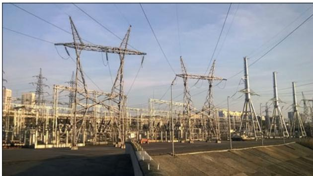
Модернизация ОРУ-220 – один из завершающих проектов комплексной модернизации Новосибирской ГЭС. К настоящему времени на станции уже завершена замена гидротурбин, что позволило увеличить её мощность с 455 до 490 МВт, силовых трансформаторов, оборудования открытого распределительного устройства 110 кВ.
