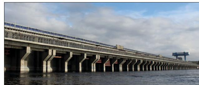
Сегодня на Саратовской ГЭС полностью обновлены 15 гидроагрегатов. Еще на трёх (ст. № 2, 12 и 20) ведутся монтажные работы. После завершения намеченной на 2025 г. замены гидротурбин (замена гидрогенераторов уже завершена) мощность ГЭС увеличится до 1505 МВт.
