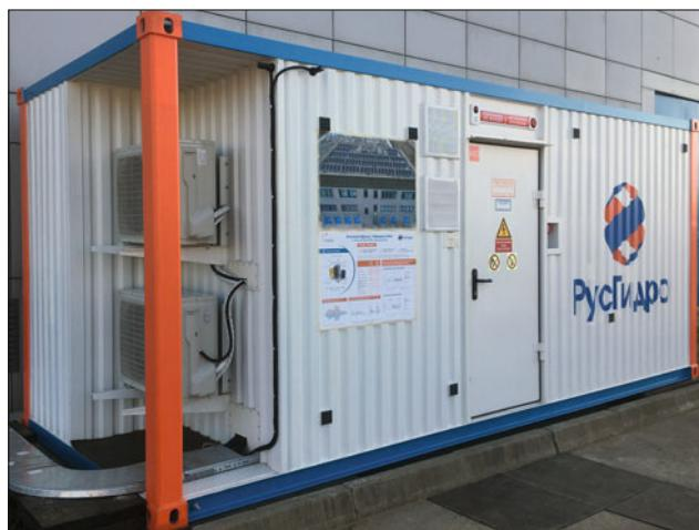
Проточные аккумуляторы состоят из резервуаров с электролитом, представляющим собой раствор металлических солей (например, раствор солей ванадия), способный переносить положительный и отрицательный заряды. В процессе прокачки электролита через разделённый мембранный резервуар, положительный и отрицательный электрод обеспечивают ионный обмен с электролитом и генерирование электроэнергии в ходе окислительно-восстановительных реакций.
