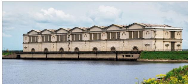
Модернизация Рыбинской ГЭС не ограничивается обновлением гидроагрегатов. К настоящему времени завершена замена силовых трансформаторов, оборудования распределительных устройств, аварийных затворов гидроагрегатов и сороудерживающих решеток, планируется замена затворов водосбросной плотины.
