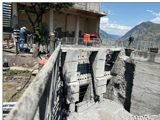
На сегодняшний день полностью демонтированы старые турбины, генераторы и предтурбинные затворы. Завершается монтаж комплектного распределительного устройства напряжением 35 кВ, после его ввода в эксплуатацию начнётся обновление распределительного устройства 110 кВ. Ведутся работы по капитальному ремонту здания ГЭС с сохранением его исторического облика.
