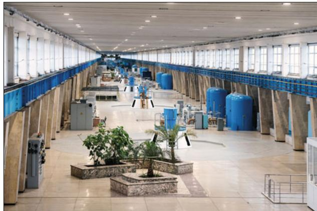
В настоящее время на Саратовской ГЭС заменены генераторы на всех гидроагрегатах и 19 гидротурбин из 24. Продолжаются работы по замене гидротурбин на гидроагрегатах ст. № 11 и 15. Помимо обновления гидроагрегатов реализуется ряд мероприятий для документального оформления увеличения мощности. В частности, ведутся работы по замене систем возбуждения генераторов.
