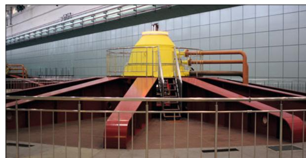
В ходе модернизации, продлившейся менее года, были заменены гидротурбина, генератор, вспомогательное оборудование, обновлена система автоматического управления гидроагрегатом. Монтаж выполнили со-
