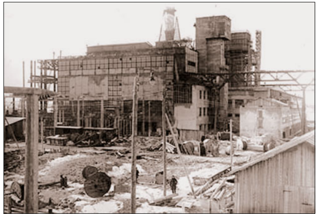
27 марта 1933 г. в Ленинградской энергосистеме состоялся торжественный пуск Дубровской ГЭС-8 – первой электростанции страны, полностью построенной советскими специалистами. На фото: строительство Дубровской ГЭС, начало 1930-х годов (сейчас – Дубровская ТЭЦ, г. Кировск, Ленинградская область)
