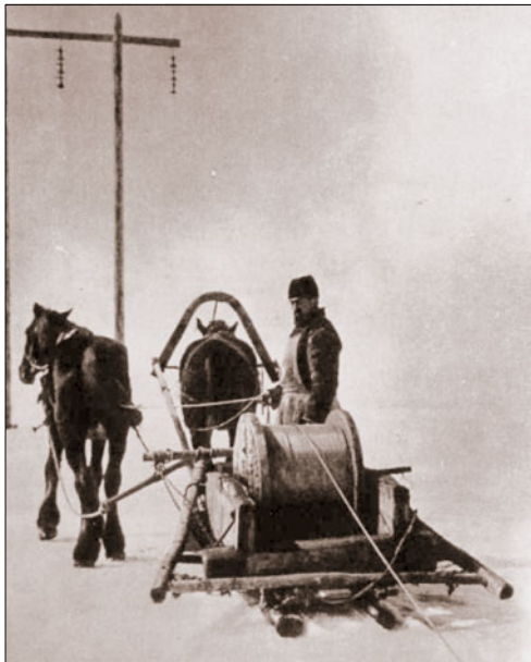
Раскатка проводов на ЛЭП. 1930 г.
