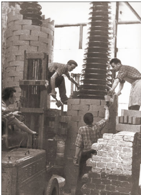
Выгрузка фарфоровой покрывки из печи. 1967 г.
