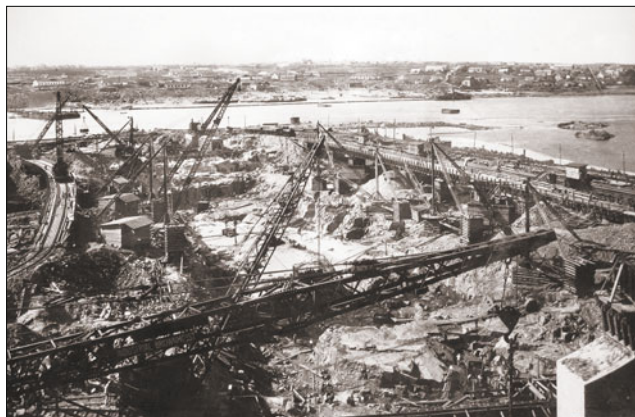
Строительство ДнепроГЭС, 1929 г.
