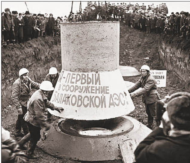
Блок № 4 Балаковской АЭС установленной мощностью 1000 МВт (начал работу в 1993 г., стал крупнейшим вводом десятилетия). На фото: торжественная закладка фундамента, 1980 г.
