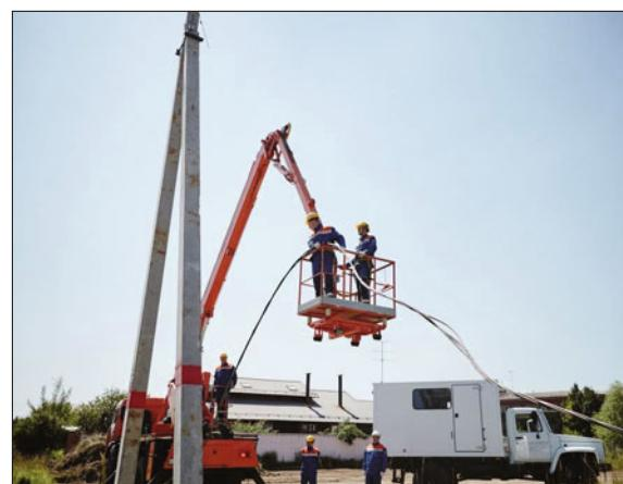
Самонесущий изолированный провод отличается от обычного повышенной пропускной способностью, высокой прочностью и более длительным сроком эксплуатации. Кроме того, он более надёжен при гололёдообразовании, устойчив к обрывам даже при неблагоприятных погодных условиях. СИП прокладывается в первую очередь в лесной местности – этот тип провода лучше выдерживает падение деревьев в случае непогоды.
