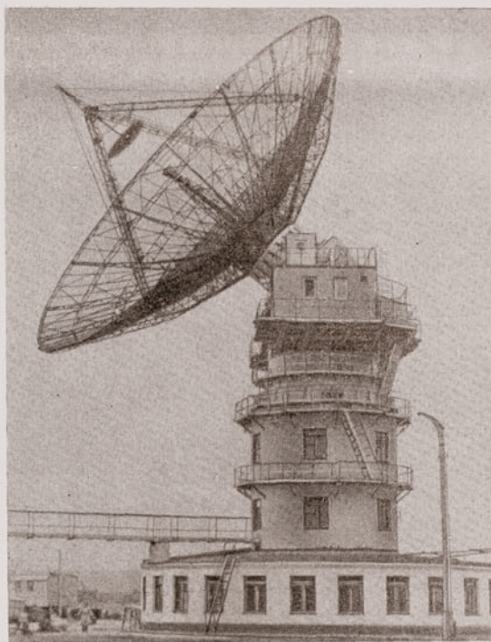
Ретрансляционная станция системы «Орбита», в разработке которой принимали участие преподаватели и инженеры радиотехнического факультета.
