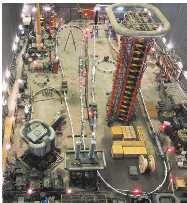
Ресурсные испытания кабельной системы 330кВ
