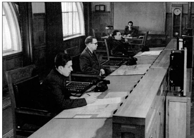
Диспетчерский щит Мосэнерго в 1954 г.
